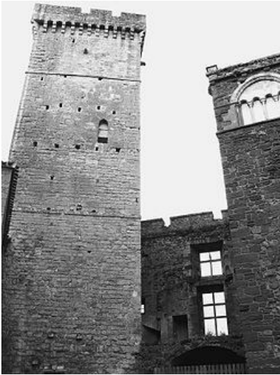
Donjon et tour de l'auditoire du château de Castelnau-Bretenoux.
