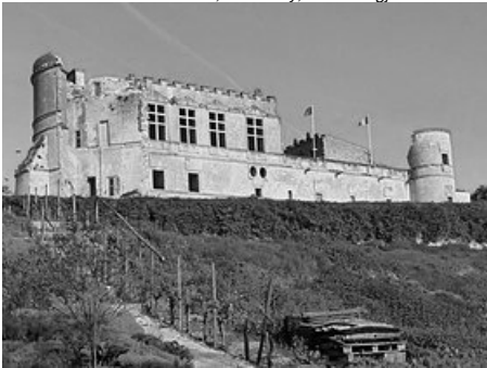
Façade est du château de Bouteville.
