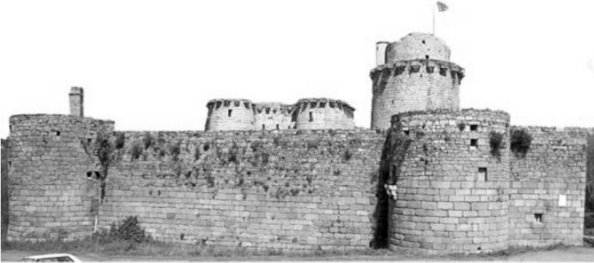
La construction du
